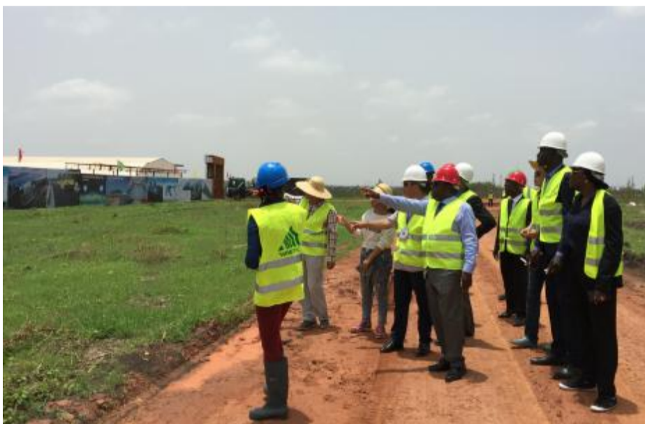
CORIS 国际银行高管一行视察项目工地现场。
