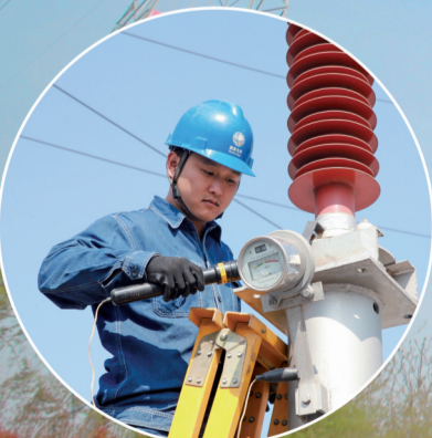
对电网设备进行春检预试
