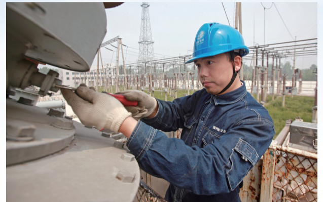
对电网设备进行例行试验和设备定检
