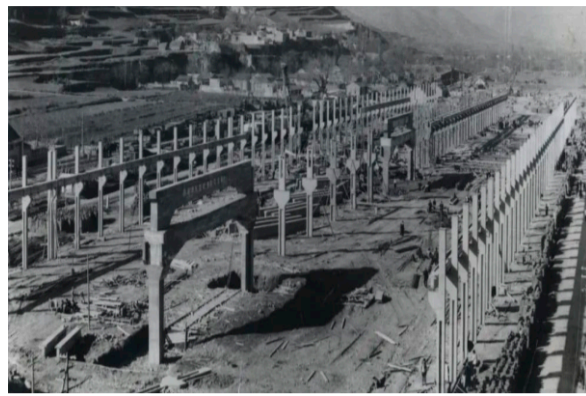
图为陕建十一建集团原工程一处承建的宝鸡钢管厂
