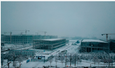
第一工程公司 冯瑞涛、吕卓云 摄 一带一路项目
