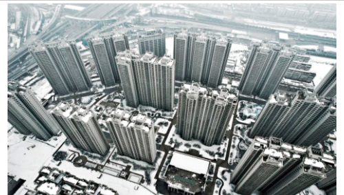
第十二工程公司 陕西日报 摄 欧罗巴项目
