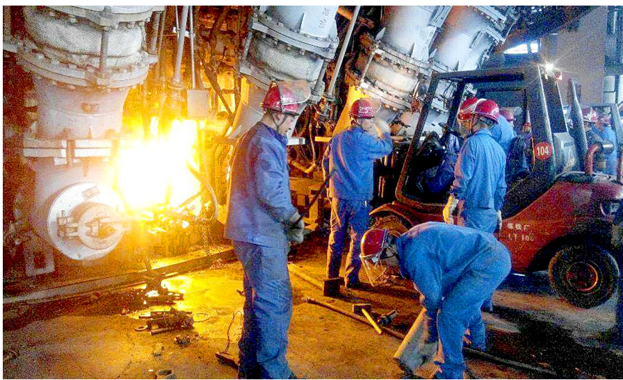
炼铁厂各基层党支部结合自身特点，开展了形式多样的“党员先锋行”活动，提高了党员立足岗位发挥作用的意识与能力，把党的组织能力有效转化为职工攻坚克难的行动能力。图为4350m 3 高炉炉前党员利用休风机会更换风口。
