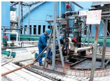
襄阳公司钳工正在维修55%酸稠浆泵。
