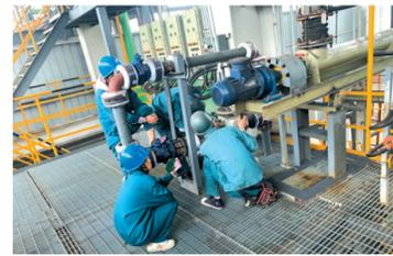
焦作基地钛一合金红石岗位的电动阀门烧毁，车间仪表人员协助项目组进行检修，保证试车正常进行。
