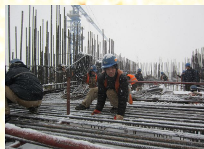
石岛湾核电项目部冒雪施工
