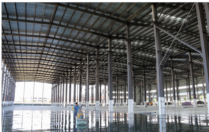
江苏金叶节能科技有限公司主要从事节能保温材料和公路、桥梁防撞设施生产。该企业在我区投资1.5亿元建设外墙保温材料及防撞设施项目,目前钢结构生产用房即将完工,办公及辅助用房的装修即将完成,项目建成后可新增开票销售收入3亿元。 杨洛平/摄 臧风华/文
