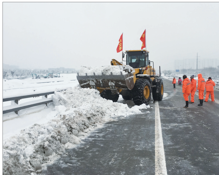
连日来,交通、城管等部门投入大量的人力、物力和机械设备,不分黑夜白昼,持续在交通主干道、城区主干道上除雪破冰,保证了过往车辆和居民的正常通行。
