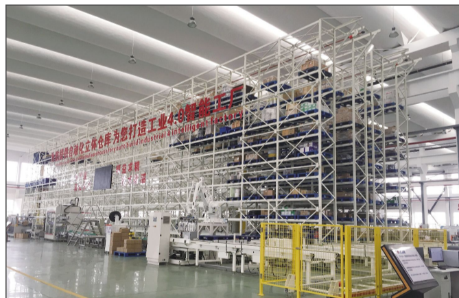
位于儒林现代产业园的江苏汤姆森智能装备有限公司拥有完善的立体仓库设计团队，致力于为客户提供自动化立体仓库。汤姆智能灌装线与自动化立体仓库的无缝对接，使生产数据共享，更加智能。整个立体仓库只需1名技术人员操作，大大减少了人工成本。 陈玲 文/摄
