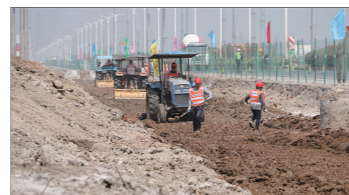
S240 改造提升工程
