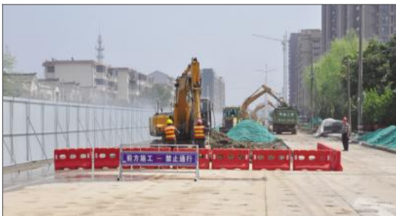
作为我区2018年老城改造的重点项目,南环一路改造工程总投资1.6亿元,目前全线已完成绿化迁移、交通导行、80%施工围挡、路面破除,正在实施综合管线迁移、沉井、雨污水管道工程。 李蕾/文 吴伟/摄
