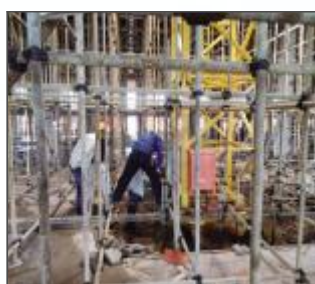
现场起重机械设备检测
