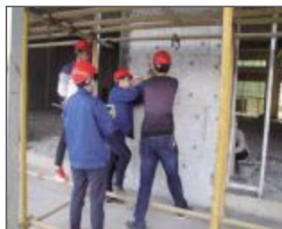
现场锚固件试验
