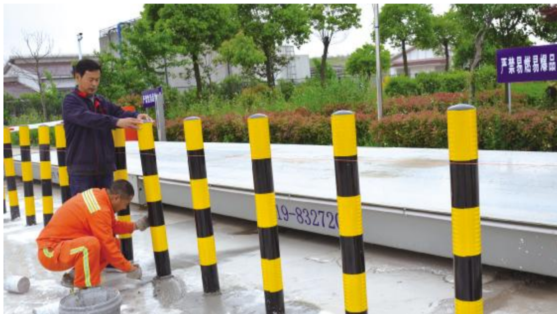
填埋场新的地磅快完工,戴惠明(左)帮工人安装防撞栏
