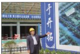
建筑施工现场
