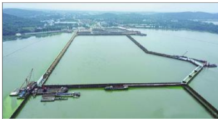
太湖隧道正式开始主体工程施工。
