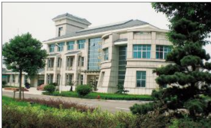
近年来，一大批水利基础设施建成并投入使用，提升了我区应对洪涝旱灾的能力和水平，保障了我区经济社会的健康快速发展。图为石桥水利枢纽。 蒋建君 文/摄
