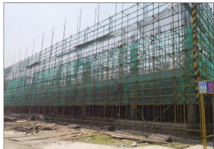
西城实验幼儿园总建筑面积7820平方米,计划总投资7200万元,已于今年3月开工建设,目前项目正在加速推进中,计划2019年春节前具备竣工初验条件。 赵小君 臧风华 文/摄
