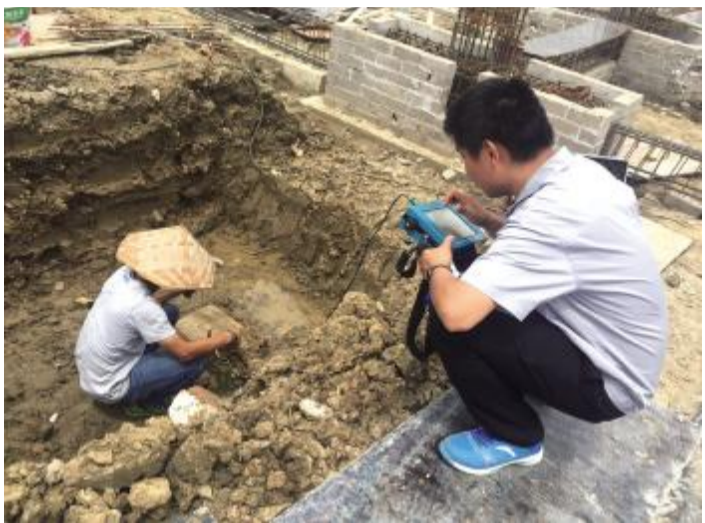
工作人员正在进行地基基础低应变法检测
