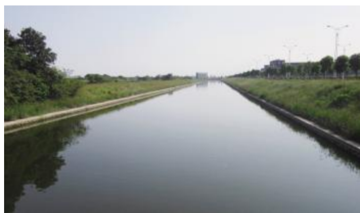
直溪镇熊家河整治后的美景
