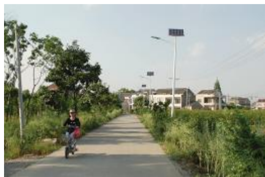
五联村加强村庄道路建设,安装太阳能路灯,改善人居环境。
