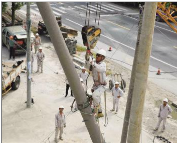
供电抢修人员在固定断杆
