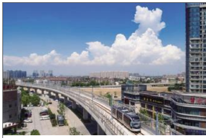
苏州有轨电车2号线开通试运营。
