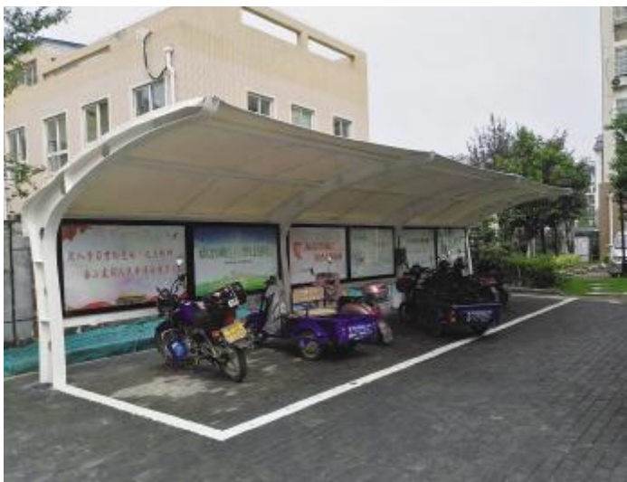
居民们的电动车正在南洲花园四期新建的停车棚内充电
