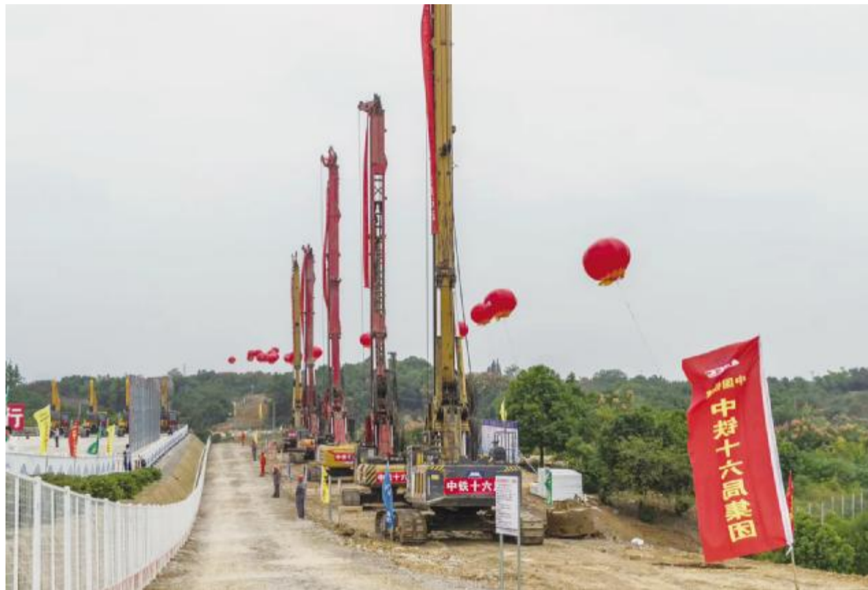
现场施工机械启动
