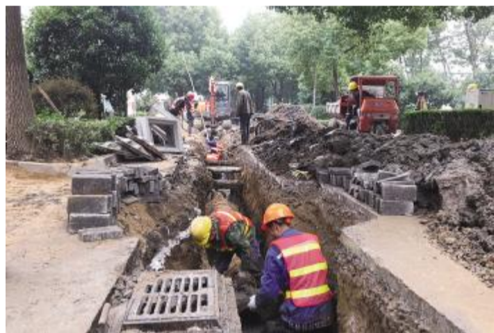
南园二村项目施工现场
