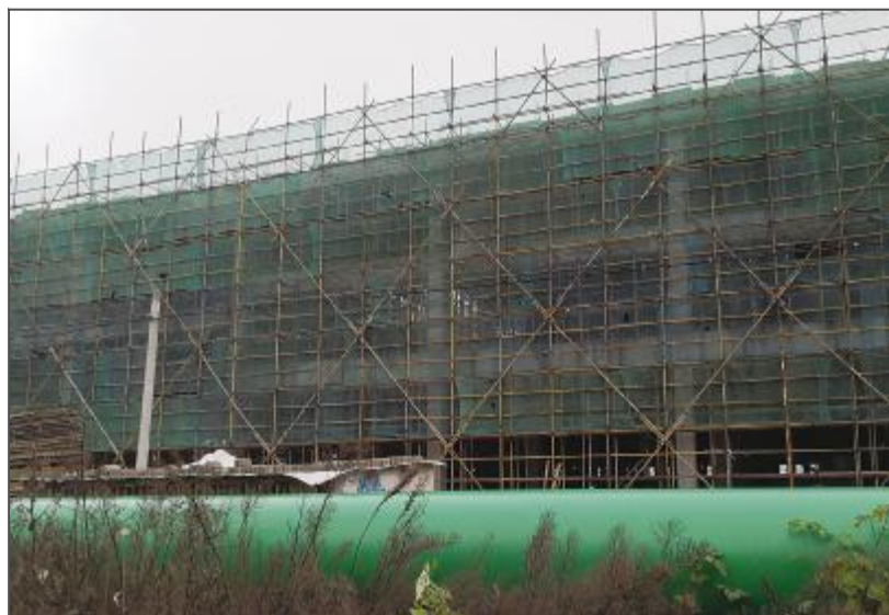
金博通小微企业众创园位于金科园盐港路北侧与建材路交汇处,计划总投资10亿元,是一个按国家级孵化器标准新建的具有辐射群体多元化、园区功能复合化、产业发展高度协同、环境友好和资源节约等多重功能的示范园区、智慧园区,集产业、商业、办公、休闲娱乐、金融、科技、电商、节能环保、效能管理、智慧服务等于一体,适合于高精尖小巨人企业和隐形冠军企业发展。该项目已于2018年3月开工,预计2019年11月全面竣工交付。 臧风华/文 赵小君/摄
