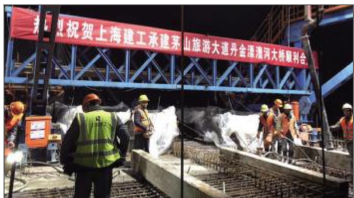
茅山旅游大道丹金溧漕河大桥施工现场
