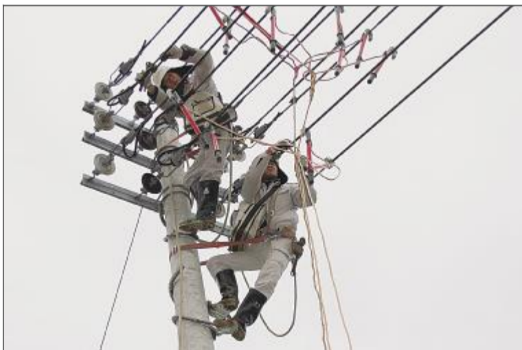
2018年12月27日,新一轮寒潮突袭苏南,气温降至零下3度。在儒林镇窑上村,供电员工正在对低压线路进行改造,将10千伏配变出线由原50平方毫米更换为95平方毫米,以保证该村46户村民的取暖需求。 邵楨/文 姜冰/摄
