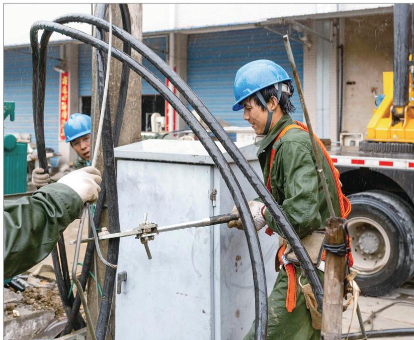
4月9日，区供电公司员工正在对10千伏冯庄线永坛时庄支线进行改造，将冯庄村2#变更换为落地箱变，将容量由原先315千伏安增大至500千伏安，未雨绸缪应对今夏用电高峰。但中午天气突变，气温骤降，并伴随着大风大雨，给施工作业带来很大不便，但工作人员仍顶风冒雨坚持作业，在计划工作时间内顺利完成了施工任务。
