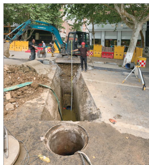
为打赢蓝天碧水净土三大保卫战，我区正大力推进污染防治攻坚行动，图为市场路上的雨污分流改造工程。 邵桢 文/摄
