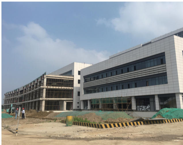
金坛第一人民医院新建项目于2014年启动,目前该项目土建已完成竣工验收,幕墙完成95%,正在进行室内装饰装修,预计今年年底达到交付使用标准,力争2020年投入使用。届时,可每日接待门诊病人5000人次以上,提供各类病床1450张。
