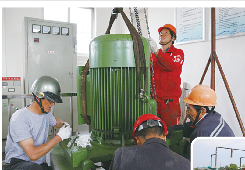
左图:6月份以来,区水利部门在汛前水利工程安全大检查基础上,对圩堤、涵洞、泵站等进行地毯式排查和试运行,确保关键时刻拉得出、打得响。图为维修养护人员对机电排灌设施进行安装调试。
