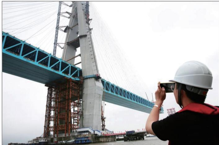
日前,沪通长江大桥南主塔顺利封顶。至此,该桥两座高达330米的主塔全部建成,标志着世界最大跨度公铁两用斜拉桥建设取得了关键性进展。沪通长江大桥全长11072米,主桥长2296米,主跨1092米,是沪通铁路全线的控制性工程,设计为上层6车道高速公路,下层4线铁路。新华社 许丛军 摄
