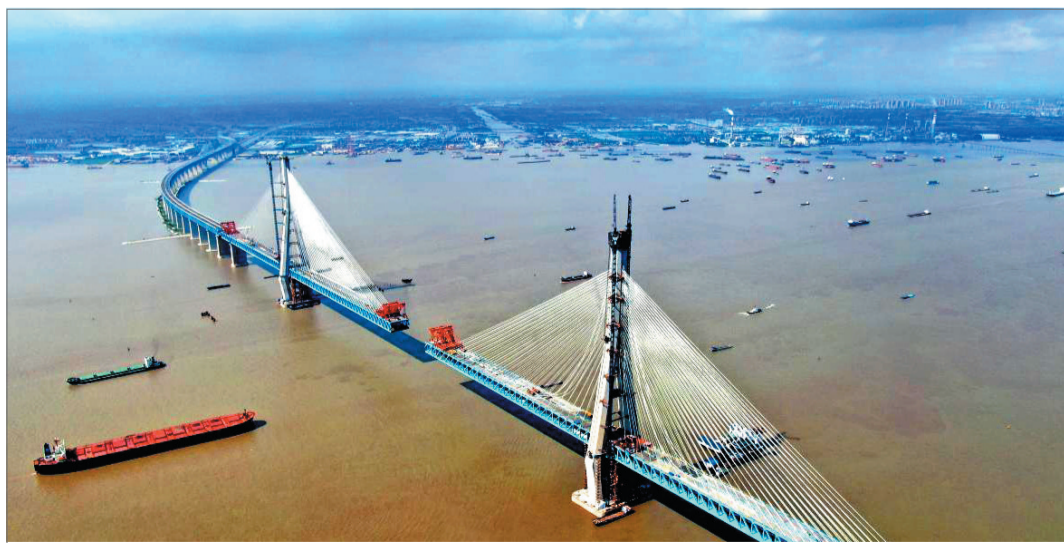
日前，由中铁大桥局承建的沪通长江大桥南岸辅助跨顺利合龙，大桥实现年内贯通目标再进一步。沪通长江大桥主航道桥采用双塔五跨斜拉桥结构，分为一个主跨、两个边跨、两个辅助跨。此次合龙在29号墩南主墩与30号南辅助墩之间。许丛军摄 光明图片
