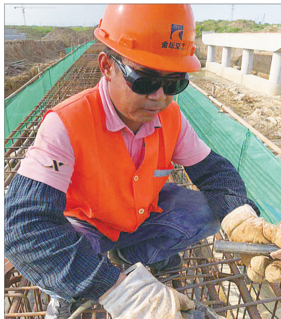
正值高温季节，金茅公路东延工程现场施工人员顶着户外高温，正在进行钢筋焊接作业。 蒋建君 吴淑琴 文/摄
