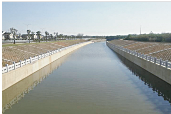
日前,新孟河延伸拓浚(金坛区)及综合配套整治工程——薛埠镇镇西撇洪通道工程通过完工验收。薛埠镇镇西撇洪通道工程位于新浮水库溢洪河与340省道交接处下游,工程总投入约7500万元,是2018年薛埠镇重点民生建设项目。该工程以防洪分流功能为主,兼有水环境补水、水系沟通功能,新建撇洪通道1408米、溢流坝1座、205县道桥1座,拆建节制闸1座、农桥2座,整治新浮水库溢洪河710米及沿线水系沟通涵闸。该工程将切实提升薛埠集镇区域防洪排水保障能力,改善集镇周边水生态环境。 陆杰 徐欢 文/摄
