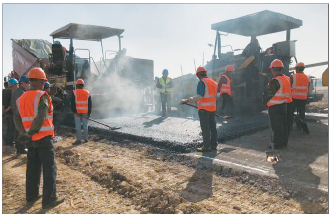
11月22日,金茅公路东延和农村公路大社线工程沥青下面层首件试铺成功,标志着这两项工程建设进入最后攻坚阶段。
