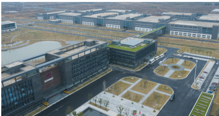
信维通信射频模组及零部件项目
