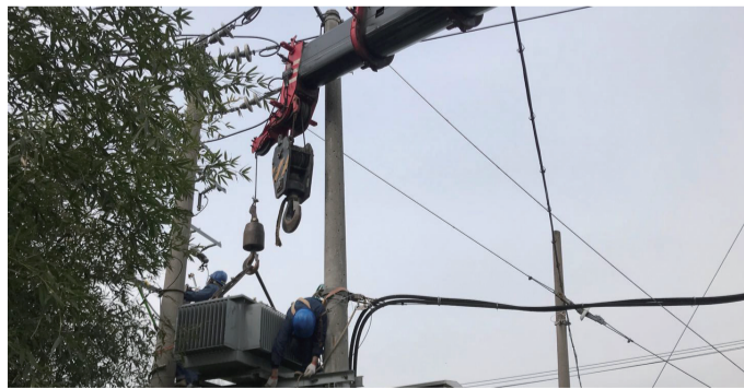
近日,10千伏良田线汀湘村配变发生异常,高压熔丝已烧两相,急需更换变压器及熔断器。金坛供电公司抢修人员第一时间抵达故障现场,在做好验电、装设接地线等一系列安全措施后,登上变压器台架,拆卸、安装每个部件、吊装变压器……经过2个多小时的通力合作,配变更换工作顺利完成,附近居民恢复了正常用电。
