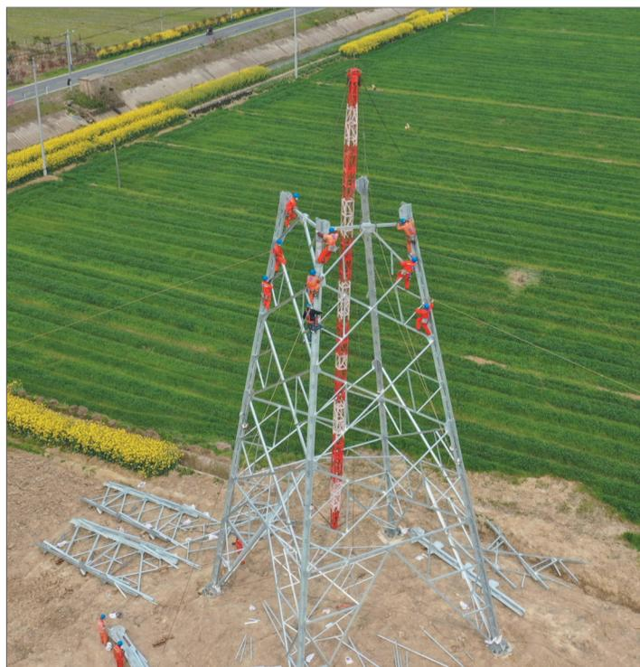
日前,在薛埠镇洮湖一方麓110千伏线路施工现场,供电公司员工正在组装20号塔。工程新建杆塔68基,线路路径长16.9公里,在迎峰度夏用电高峰期可灵活切换,优化电网。
