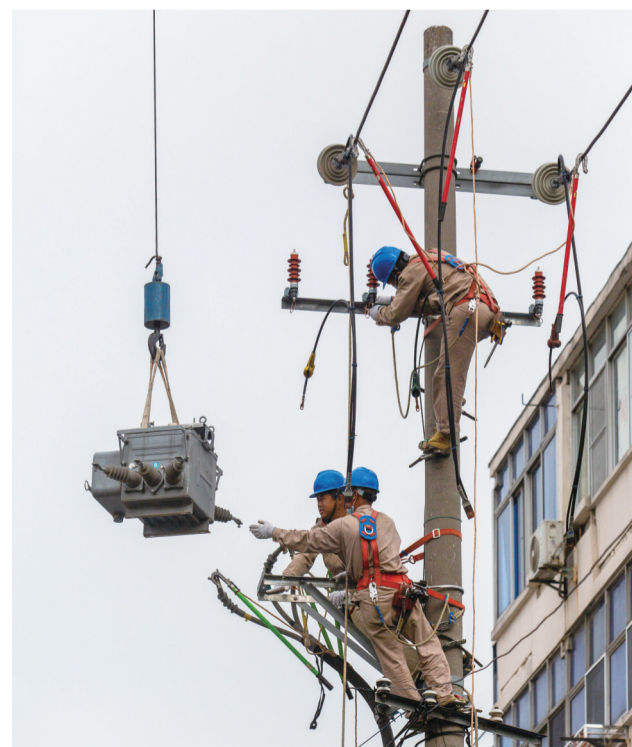
日前,区供电公司员工对10千伏社桥线、西门线、文翠线开展更换老旧电杆、柱上开关、配变刀闸熔断器等线路修理工作,保障周围居民迎峰度夏期间用电无忧。 夏冰 陈玉婷/文 张立强/摄
