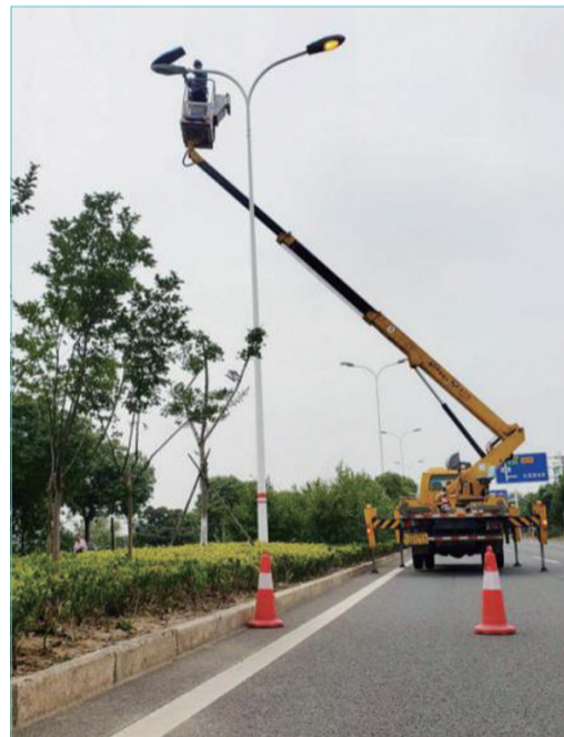
为防止漏电事故发生,区照明管理处开展雨季安全巡检工作,对损坏、故障的照明设施进行及时维修和更换,确保管辖区域内照明设施安全运行。 孙婷/文 于之乐/摄
