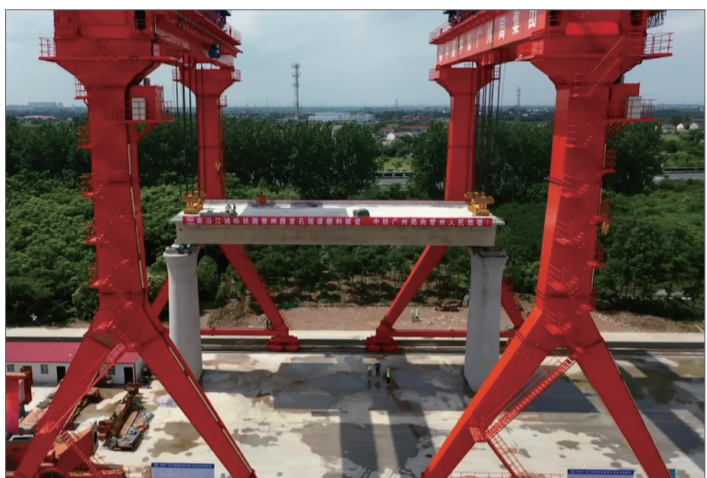
本报讯 6月19日上午，箱梁在我区成功架设，标志着苏南沿江城际铁路常州段首片苏南沿江城际铁路常州段建设
