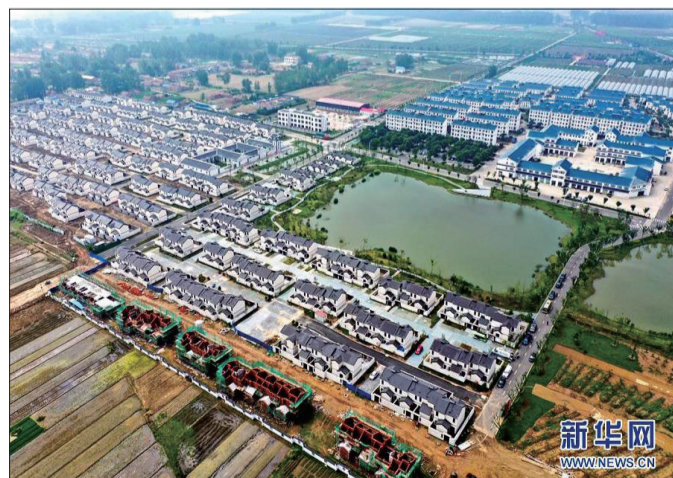
近年来,泗阳县大力推进农房改善工作,提高群众生活品质。爱园镇松张口社区农房改善项目将公共空间治理与农房改善工作相结合,抓好建筑质量的同时,注重小区整体环境建设,打造风景如画的新农村。新华社 季春鹏/摄
