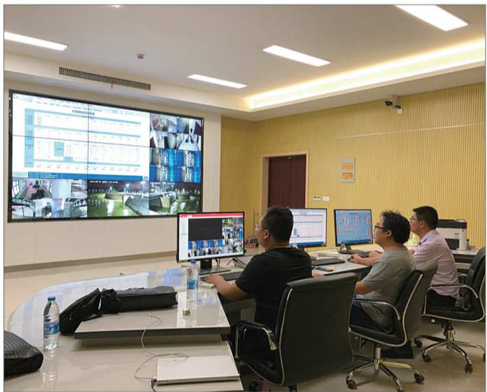
钱资湖水闸枢纽中控室监测水位状态
