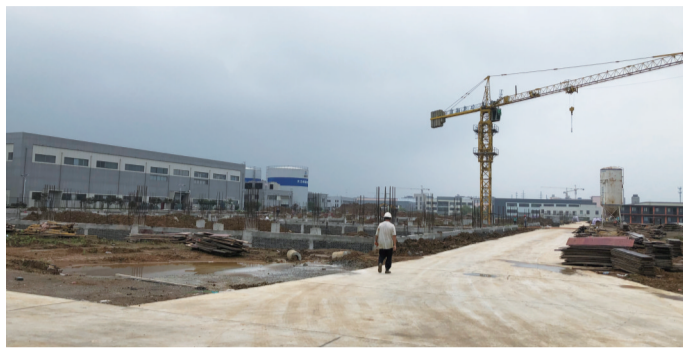
大力新科技有限公司项目建设现场
