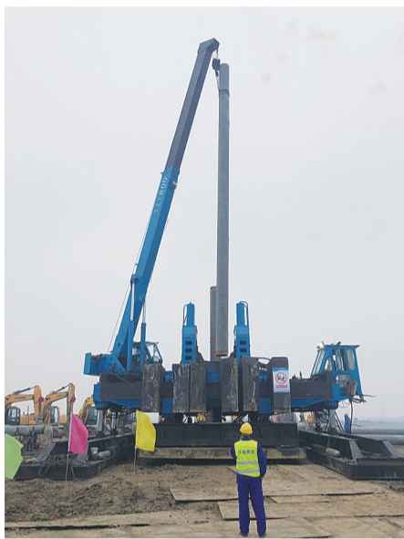
河海大学常州新校区桩基工程打下首桩
