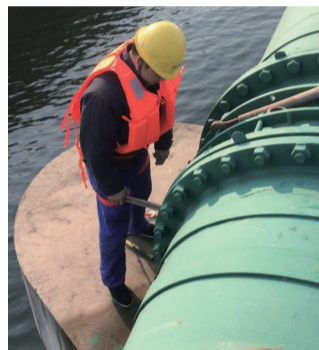
自来水公司工作人员对管道进行维护保养
