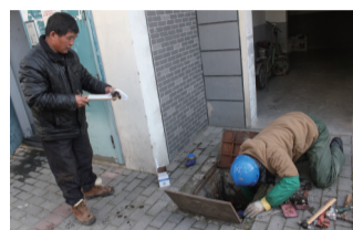
自来水公司工作人员更换冻坏的水表
