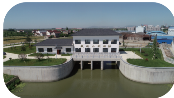
双桥水利枢纽
